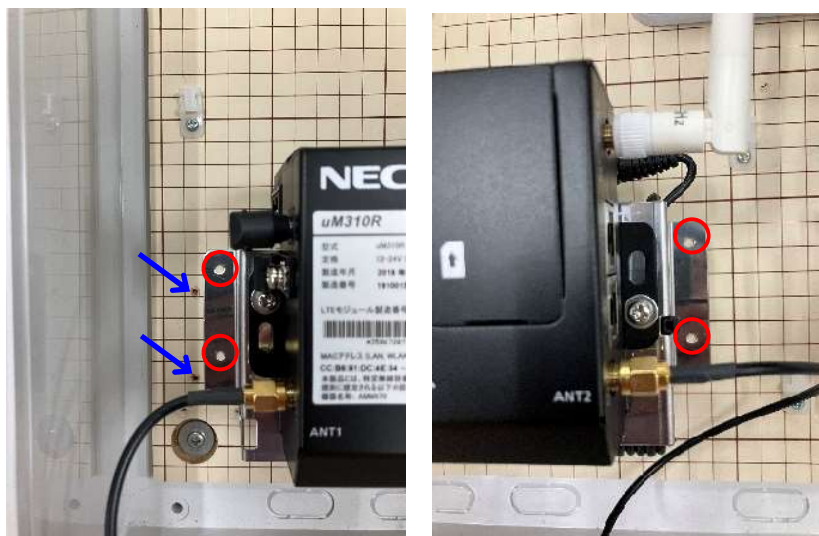
LTEルータの取付箇所（4ヶ所、赤丸部）
